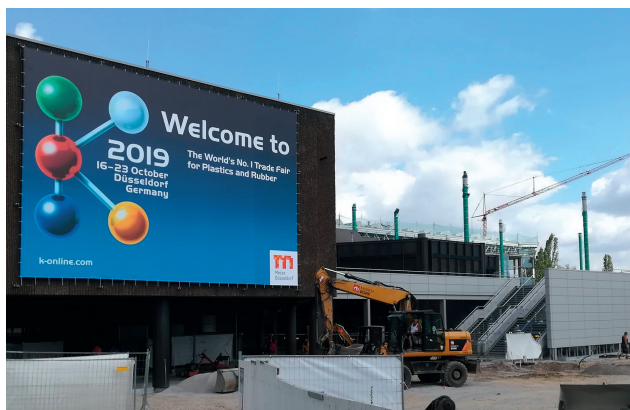
Bild 1. Bauarbeiten mit Hochdruck: Bis Ende 2019 entsteht an der Messe neben einer neuen multifunktionalen Halle mit Konferenzräumen auch ein komplett verglaster neuer Eingang Süd
